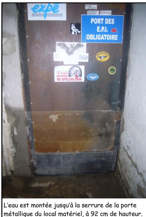
L'eau est montée jusqu'à la serrure de la porte métallique du local matériel, à 92 cm de hauteur.
