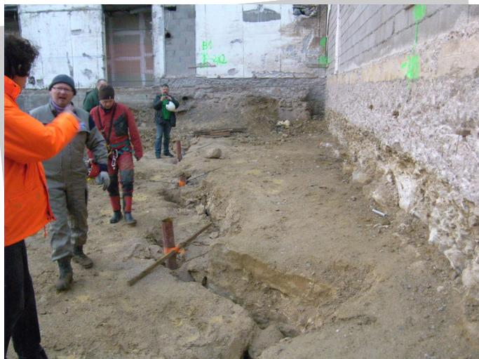
Une corde est installée, amarrée sur un mur surmontant le chantier, dûment protégée des frottements par des éléments de construction qui jonchent le chantier (bâches, gaines plastiques...).
