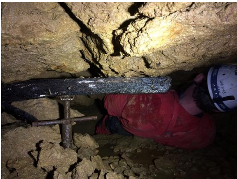
Étayage dans le laminoir d'entrée au Fond de la souche, O. Gradot
