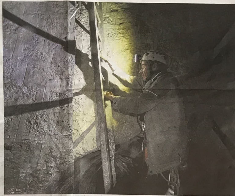
La remontée des puits d'accès se fait à l'échelle. Photo ER/E.D.
