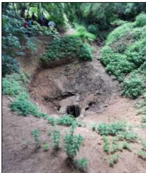
23/6/2021, 14 h 30 : niveau d'eau 4 à 5 m sous le niveau de la buse en béton
