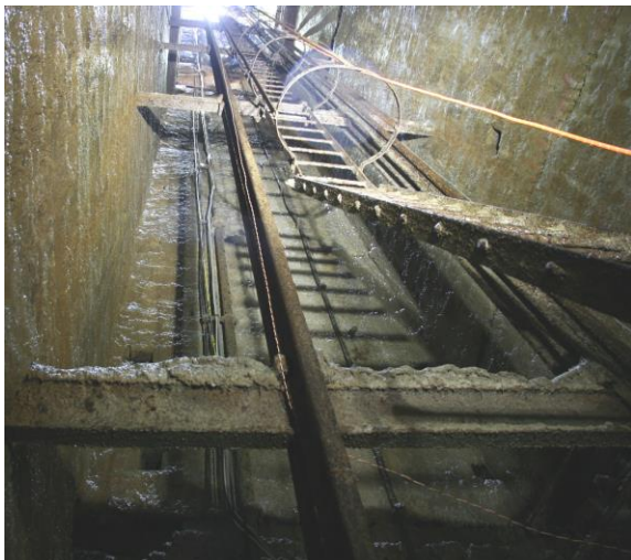
Puits de la Faille - 40 m (Benoît Brochin)
