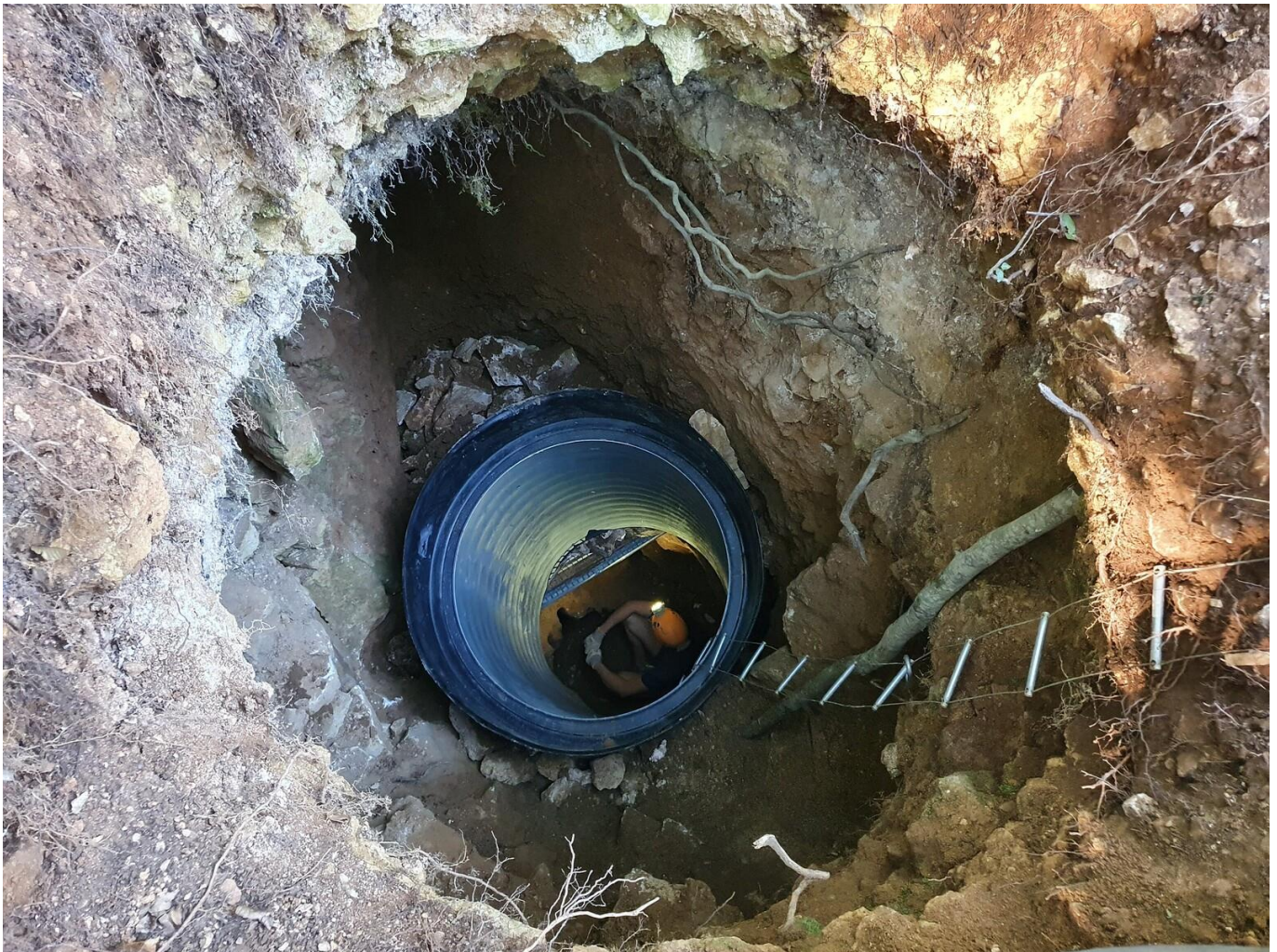
Busage du puits du Chouchen, Grotte des Sept-Salles, Pierre la Treiche (54), insertion du premier tronçon (cliché : O. Gradot, 20 août 2023)
