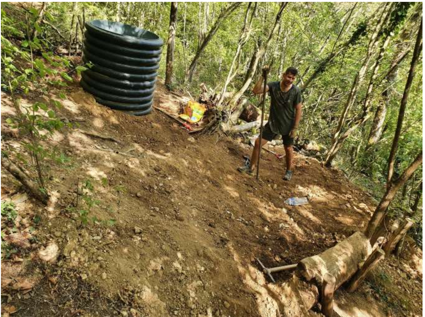
Busage du puits du Chouchen, Grotte des Sept-Salles, Pierre la Treiche (54), pose du deuxième tronçon (cliché : O. Gradot, 8 septembre 2023)
